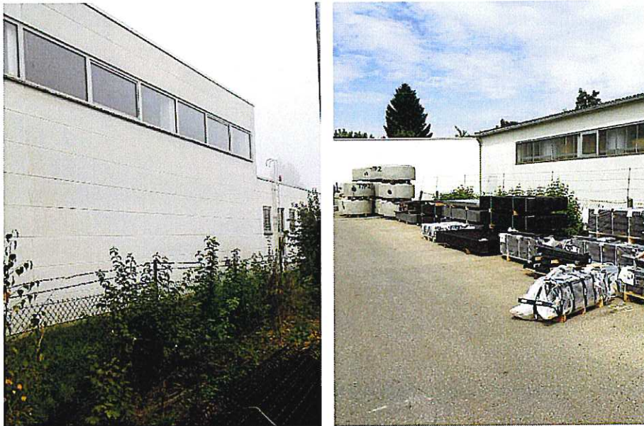
Abbildung 6 Blick auf die westliche (links) und nordwestliche (rechts) Grundstücksgrenze bzw. auf die Nachbarbebauung, September bzw. Juli 2020
