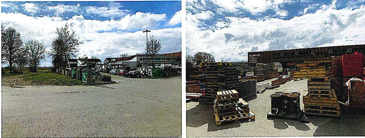
Abbildung 5 Blick nach Süden auf den Zufahrtbereich (links) und das bestehende Gebäude und Lagerplatz (rechts), Juli 2020
